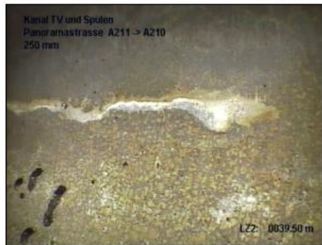
39.50 m Oberflächenriss (Haarriss) längs 5 Uhr Foto 12
